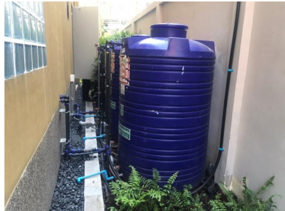
รูปที่ 2-44 ถังเก็บน้ำของอาคารชุดพาณิชย์
