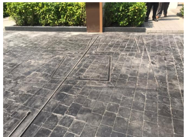
รูปที่ 2-40 บ่อหน่วงน้ำของอาคารชุดพักอาศัย
